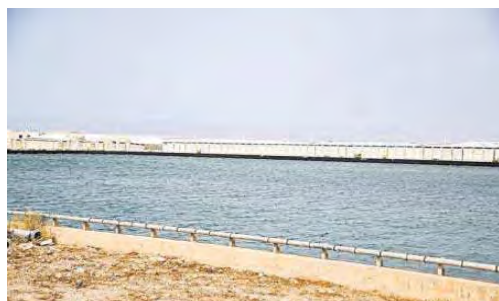
La balsa 1, junto a la propia desaladora, desbordante de agua.
